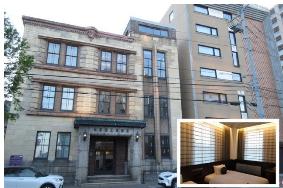
今回のホテル「OMO5 小樽 by 星野リゾート」。向かって左側が「旧小樽商工会議所」をリノベした南館。ここに泊まりました。
